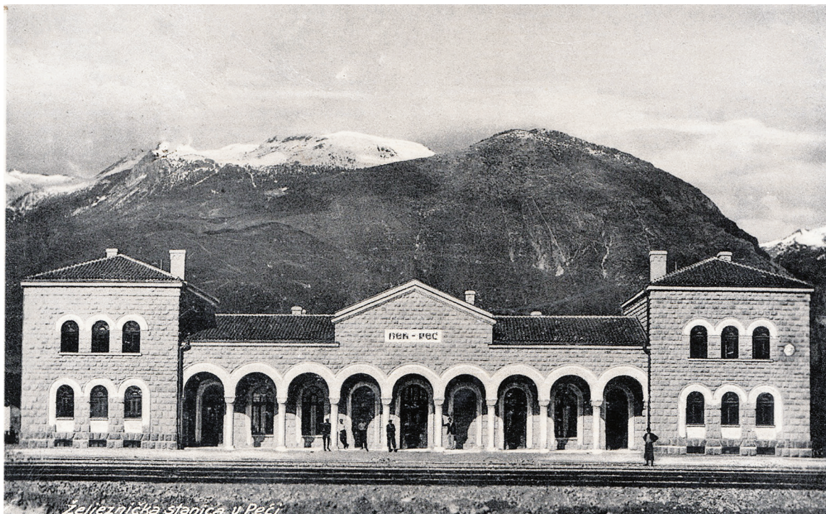
Сл 3. Зграда Железничке станице у Пећи. / Fig. 3 The Railway Station Building in Peć
