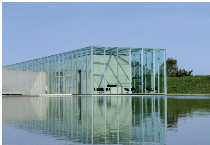
Сл. 19. Фондација Лангн, Нојс, Немачка, 2004. Fig. 19. Langen Foundation, Neuss, Germany, 2004
