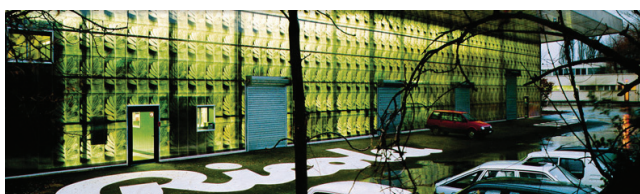
Сл. 21. Херцог и де Мерон: Фабрика и складиште, компанија Рикола, Мулхаус-Брунштат, Француска, 1993. Fig. 21. Herzog & De Meuron: Production and Storage Building Mulhouse-Brunstatt, France, 1993
